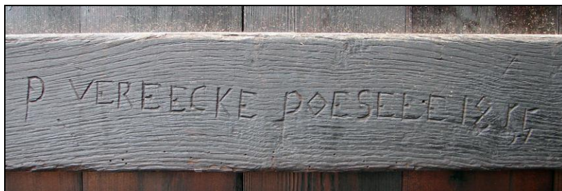
OMD - P Vereecke uit Poesele werkte in 1855 als knecht op het 'Klein goed ter Meersch' en kerfde zijn naam in de toegangspoort van de grote schuur
